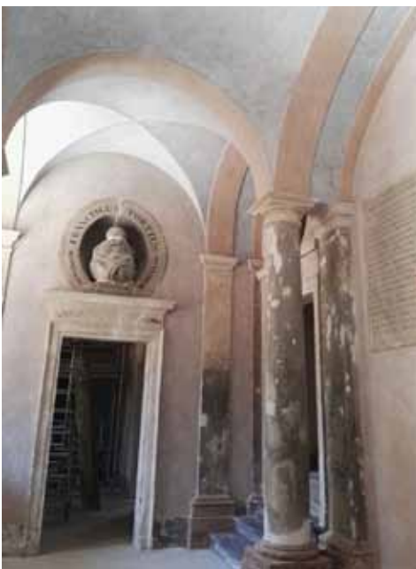
Scorcio dell'atrio di ingresso al Teatro Anatomico prima e durante il restauro, angolo sinistro
