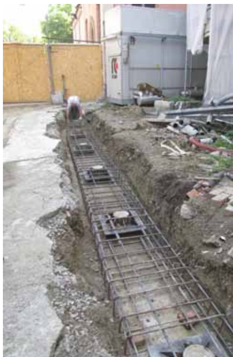
Particolare della fondazione del muro di recinzione nella fase precedente al getto del cordolo
